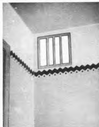
Abb. 1. Der Lautsprecher sitzt nahe dem Deckeneck in der Mauer, durch einen mit Seide hinterpannten Rahmen abgedeckt.
