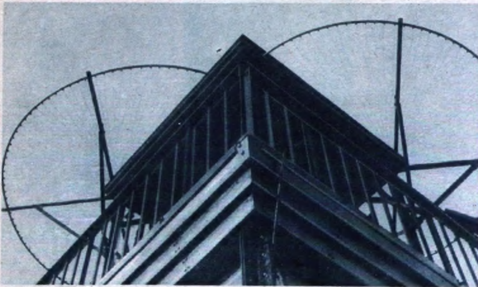
Die Spitze des Berliner Funkturms krönen jetzt die 2 Antennen für die beiden Fernseh-Ultrakurzwellen-Sender der Deutschen Reichspost. Phot. Gulliland.
