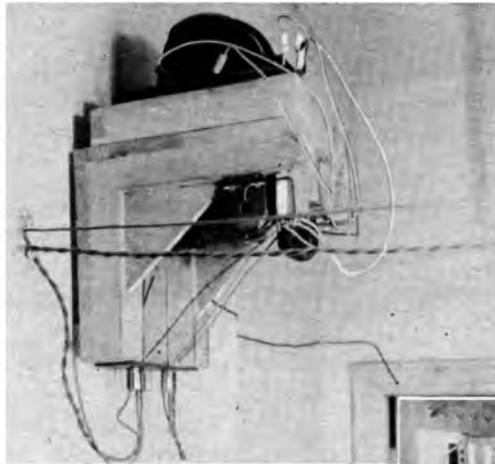
Abb. 1. Der Gleichstrom-Wechselstrom-Umformer auf seinem Konsol.
