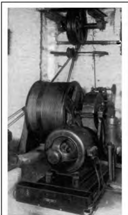
Ein entstörter Aufzugsmotor. Im Vordergrund deutlich sichtbar die Drossel im Blechgehäuse.
