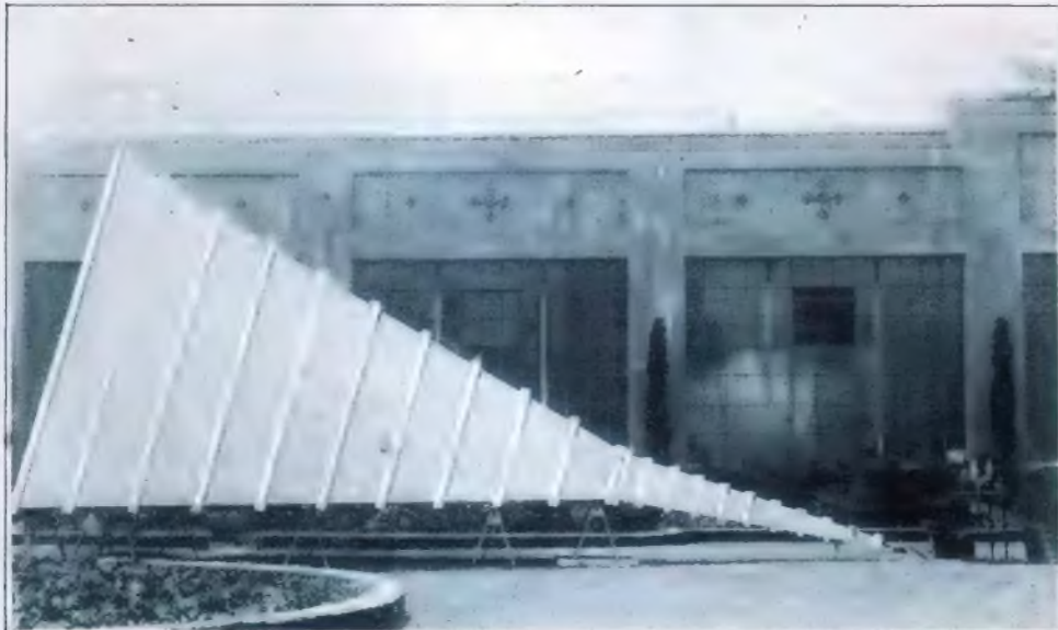
Noch ein Riesenlautsprecher amerikanischer Konstruktion, völlig aus Holz gebaut
