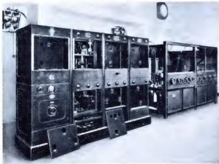
Abb. 5. Der Gleichwellen-Untersender Magdeburg; links der Frequenzwandler und Vorverstärker, rechts Steuer- und Hauptsender
