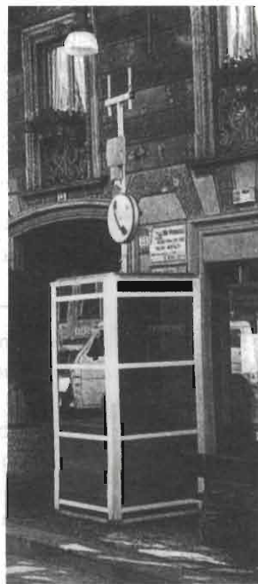
Foto 1 - Stazione radio DECT installata sopra una cabina Telecom.
