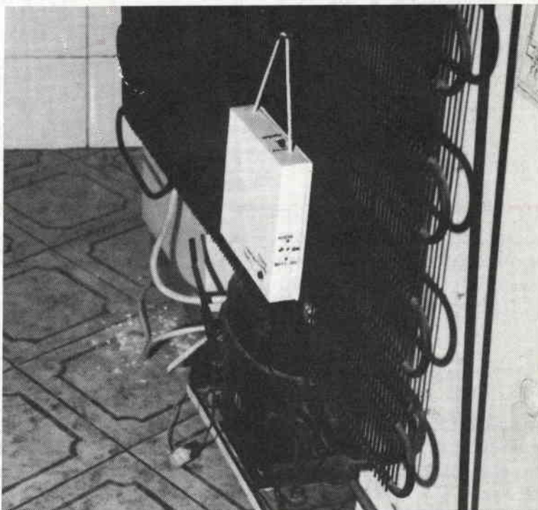
figura 1 - Come si presenta la realizzazione.
