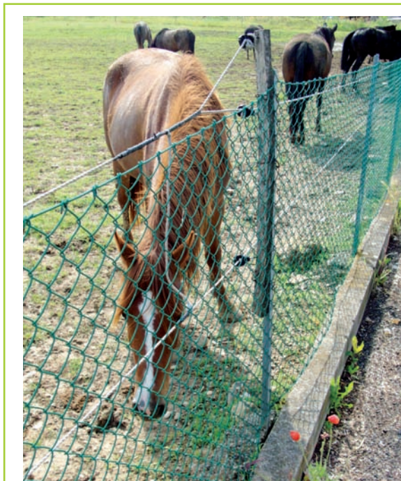
Figure 12 : Si le câble métallique est installé sur une clôture déjà existante, vous devrez l'isoler efficacement des piquets en métal au moyen d'isolateurs en plastique ou en céramique.
