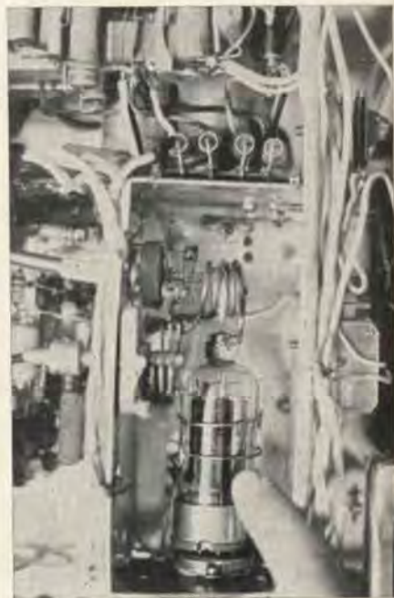
Particolare della gabbia di neutralizzazione
