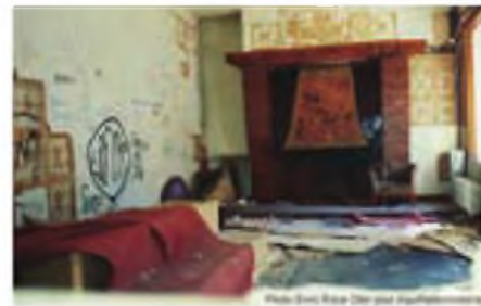
El locutorio de la chimenea en un estado lamentable.
