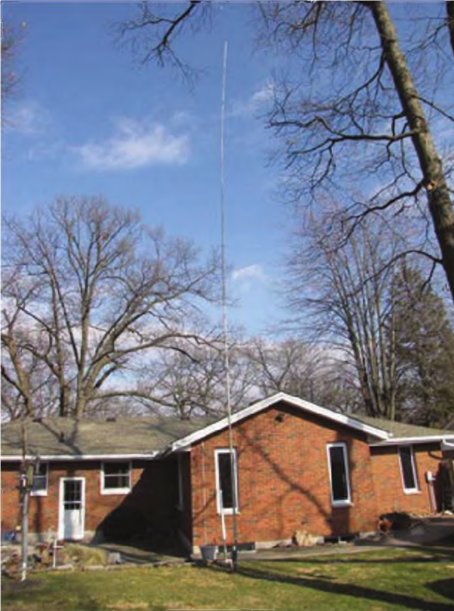
Foto E: Vista de la antena con el radiante de 17 metros. Esta foto fue tomada en la primavera de 2009.
