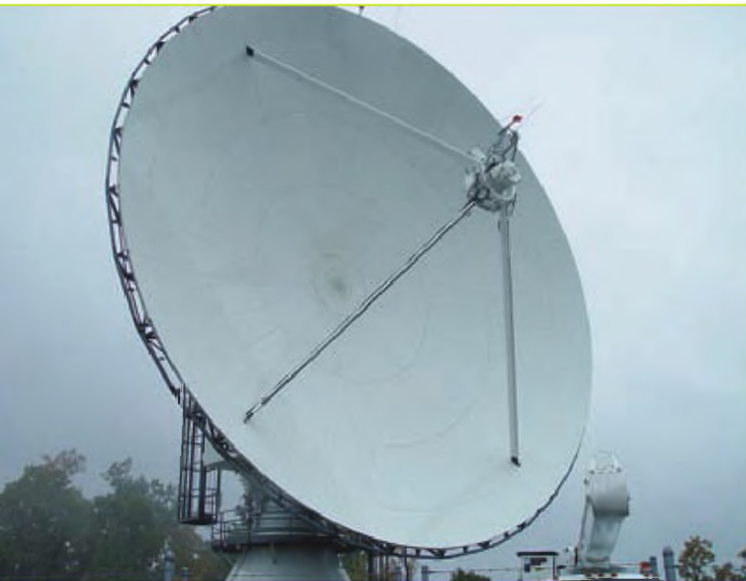
Vista lateral de la gran parábola de 21 m del Centro Científico Espacial de Morehead. (Foto N6CL)
