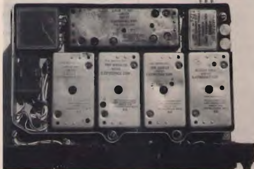
③ Vista dell'interno, lato superiore.
