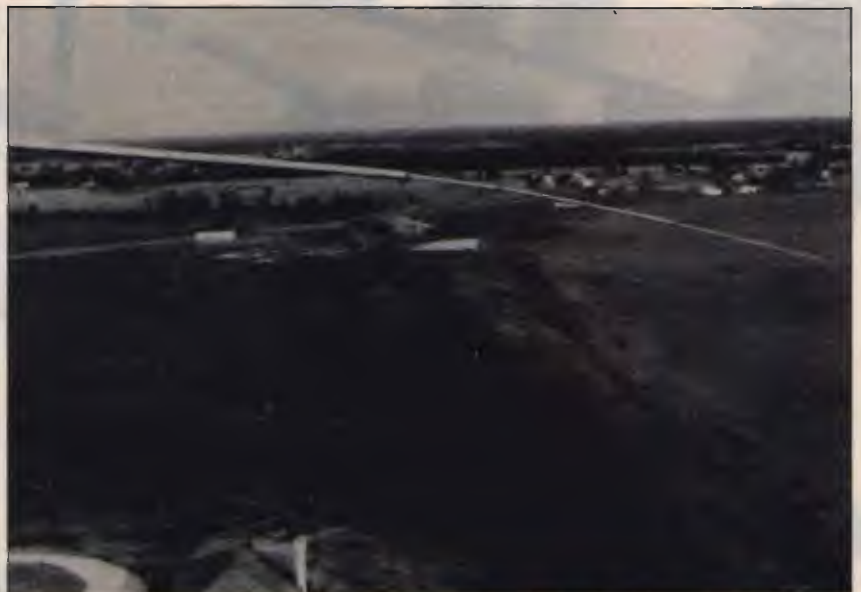
figura 1 La vista dalla cima del traliccio della Sputafuoco; si notano le altre antenne della stazione e la notevole curvatura degli elementi.
