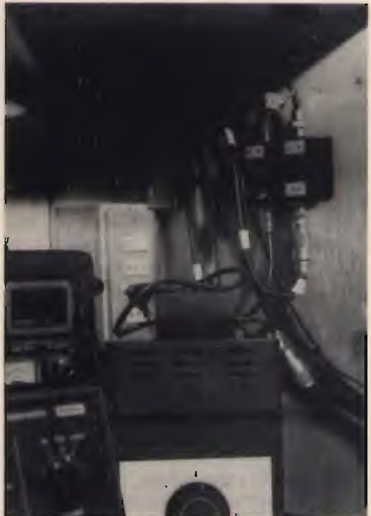
L'invertitore d'antenna installato in un angolino della stazione, a portata di mano.
