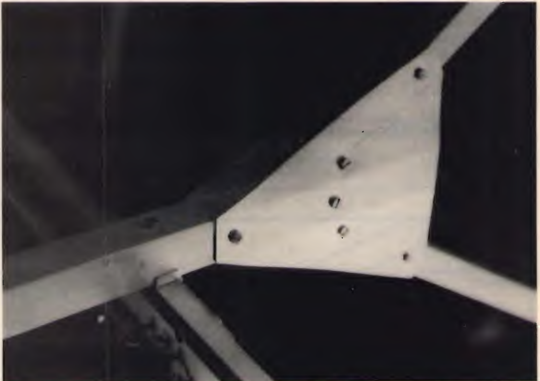
Particolare dei lamierini "a sandwich" che bloccano i due sostegni posteriori dei riflettori.
