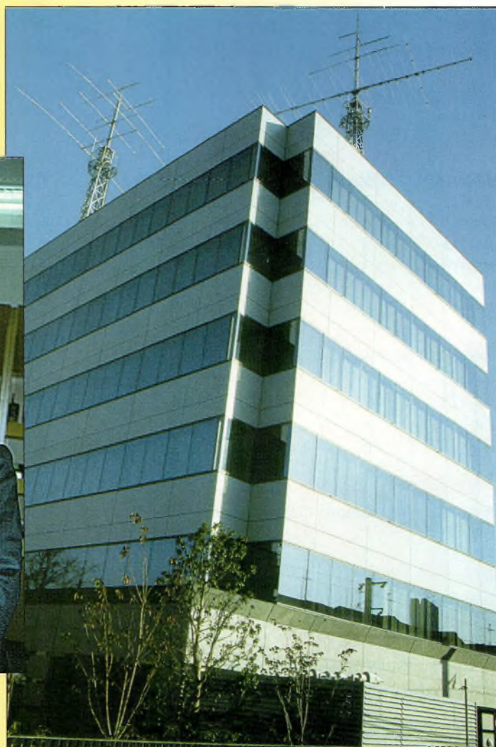
Le bâtiment de ICOM à Osaka, Japon. Les imposantes antennes sur le toit permettent de le trouver plus facilement ! (Photos de Eve Vigil, KF6NEV)
