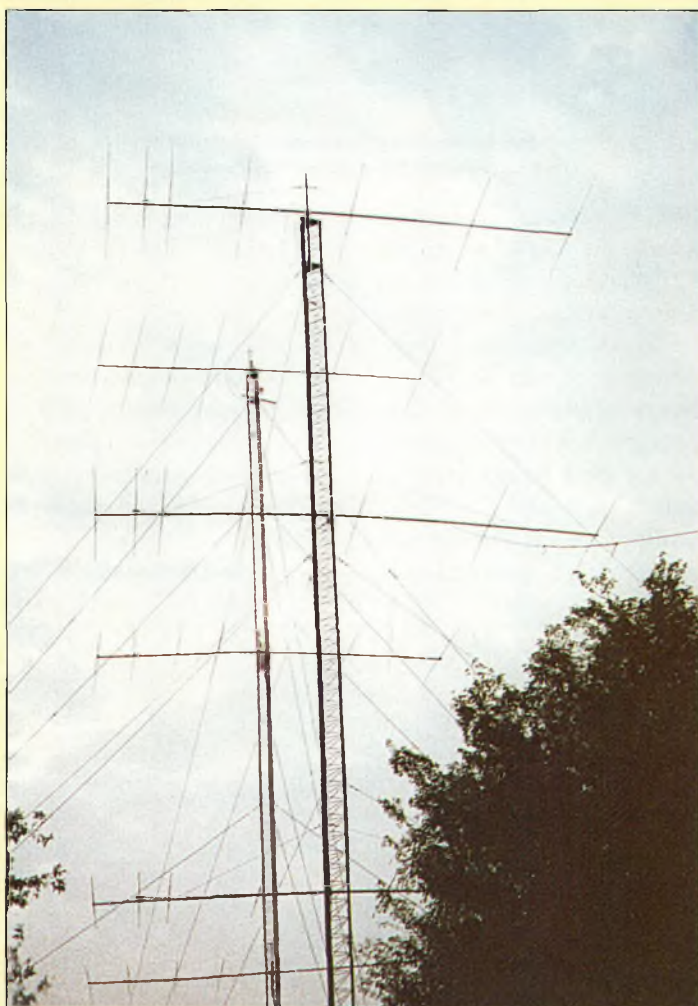
Remarquez que les câbles de hauban se détachent du pylône à un angle modéré. Les câbles de hauban sont généralement attachés à de larges barres en acier encastrées dans des blocs en béton (ou à des ancrages de terre, si la situation le permet). (photo de K2RED)
