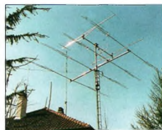
Les antennes, le pylône et tout ce qu'il faut pour le trafic via les satellites.
