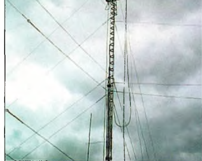
Travaux sur les aériens.
