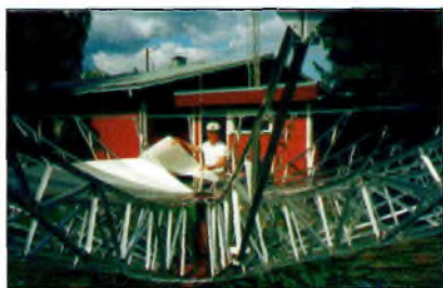
Construction d'une parabole chez OH20G.
