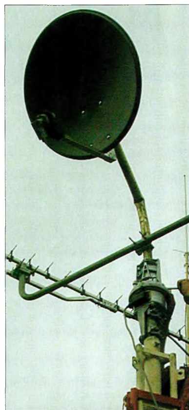
Un tube de 40 mm plié à 30 degrés évite les modifications sur les attaches de la parabole.
