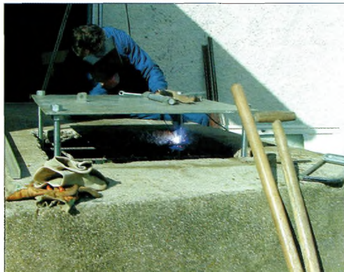
Une fois terminées les soudures, l'intérieur du quai sera rempli avec 3 m 3 de béton.
