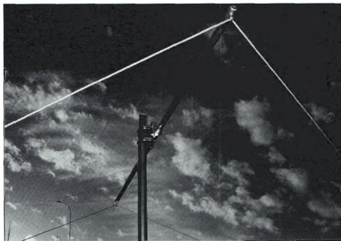
Mise en place du cordage.
