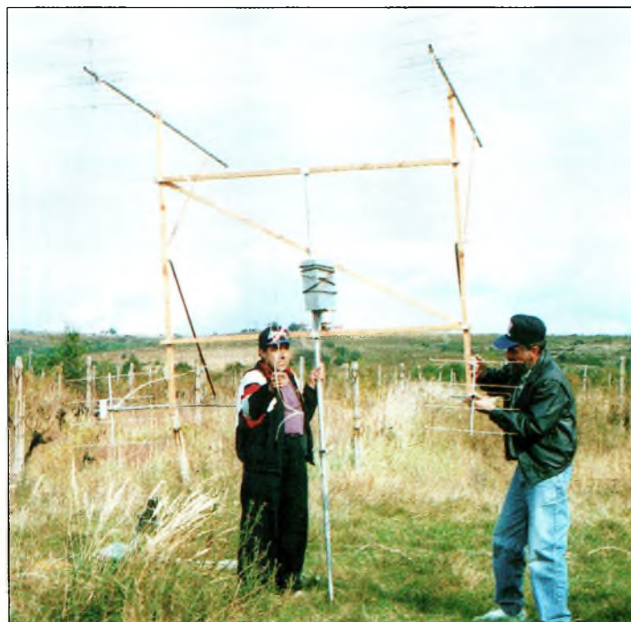
Vivi, YO2AFS, et Liviu, YO2BCT, installent la 4 x 16 éléments 432 MHz pour le contest IARU, en KN05TR.
