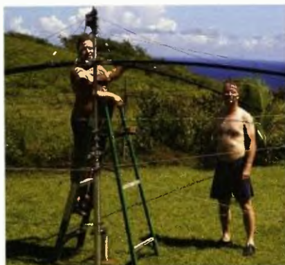
Obr. 4. Stavba spiderbeamu
