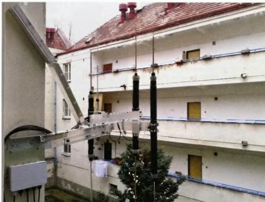
Obr. 9. Pohled na montáž antén
