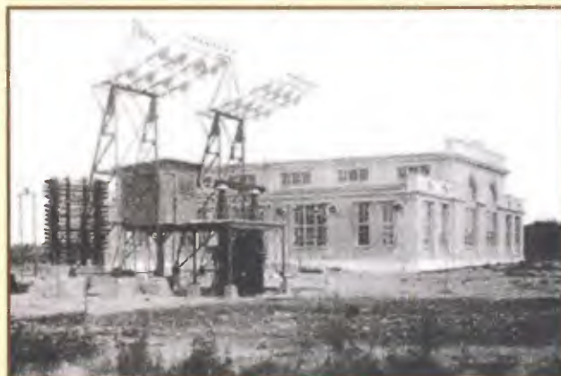
Obr. 9. Budova vysílače Babice
