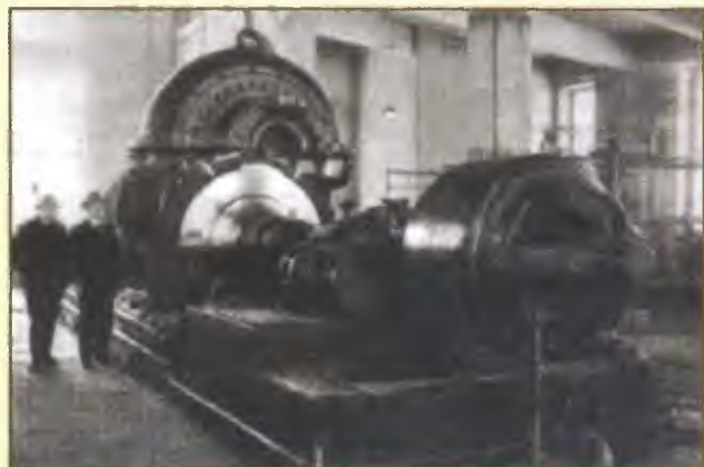
Obr. 8. Montáž generátoru v Babicích
