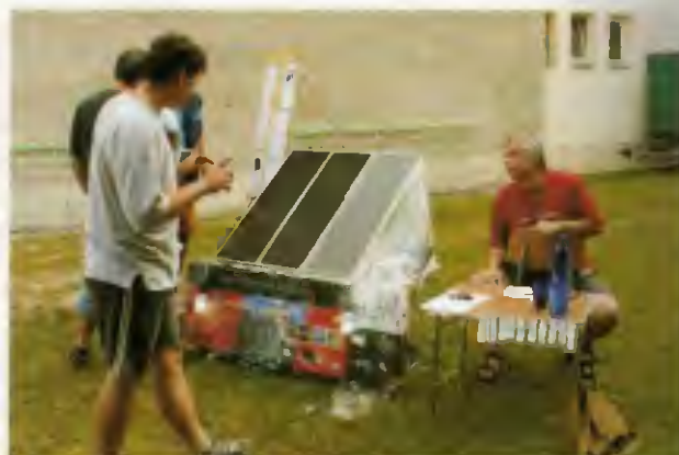
Obr. 9. Před vstupem do Sportovní haly byla demonstrována sestava FV panelů, určená pro místa bez elektrické sítě (chaty karavany) s výkonem 60 W
