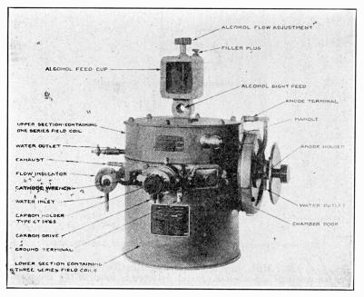
Fig. 45.-The Arc Converter.
