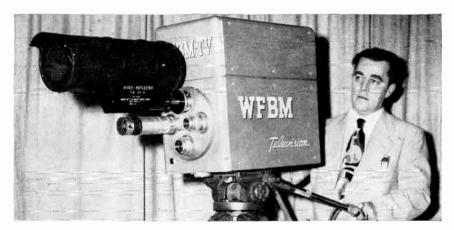
Fig. 5-4. Video Reflectar lens in use.
