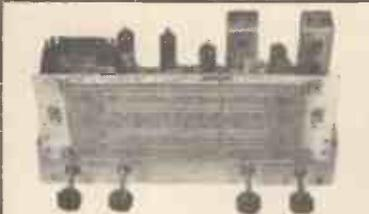
1958 RADIOGRAM CHASSIS THREE WAVEBANDS FIVE VALVES S.W. 16m.-50 m. LATEST MULLARD M.W. 200 m.-550 m. ECH42, EP41, EBC41, LW. 800 m.-2,000 m. EH41, EZ40
