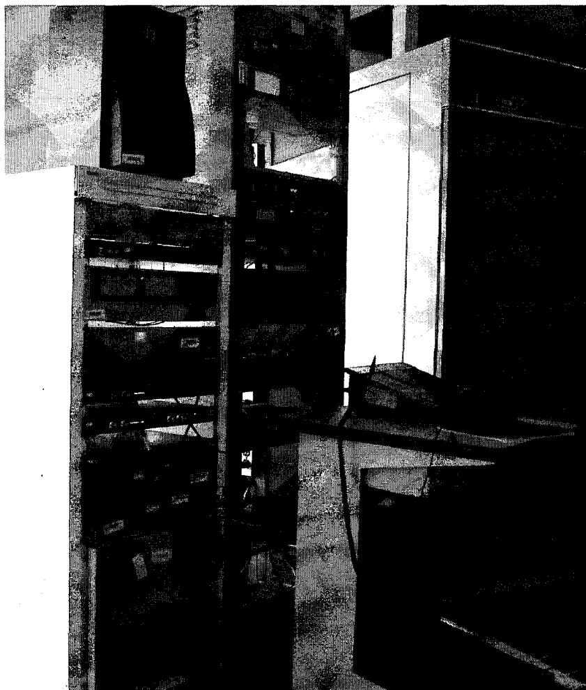
Equipos de transmisión.
