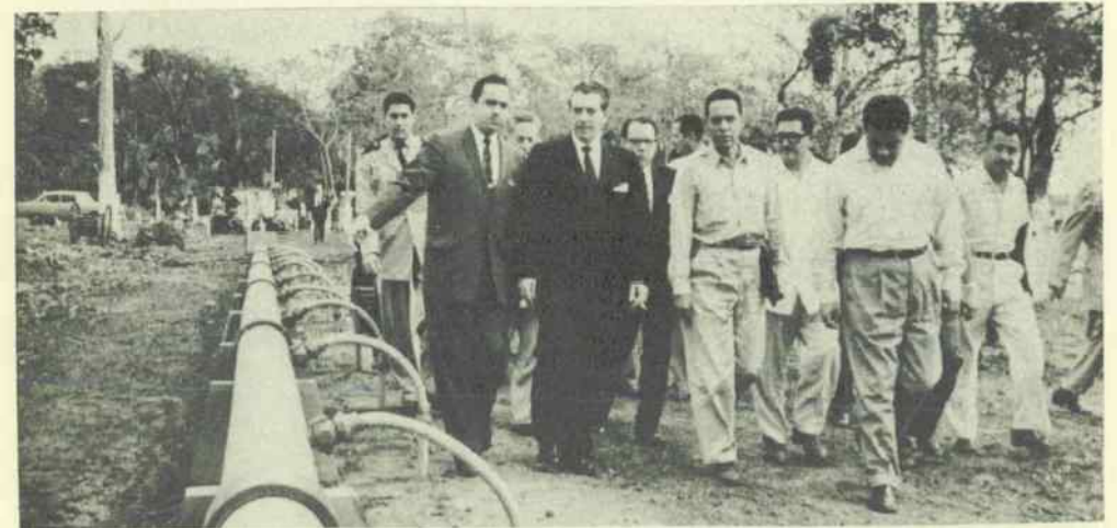
En todas partes se ponen en servicio nuevas obras que benefician a todos los sectores de Tabasco. Aquí, el señor Presidente y su comitiva inauguran las obras de introducción de agua potable en Cárdenas.
