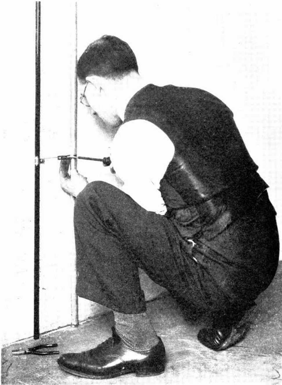
Fig. 1. —EARTHING THE CONDUIT.
