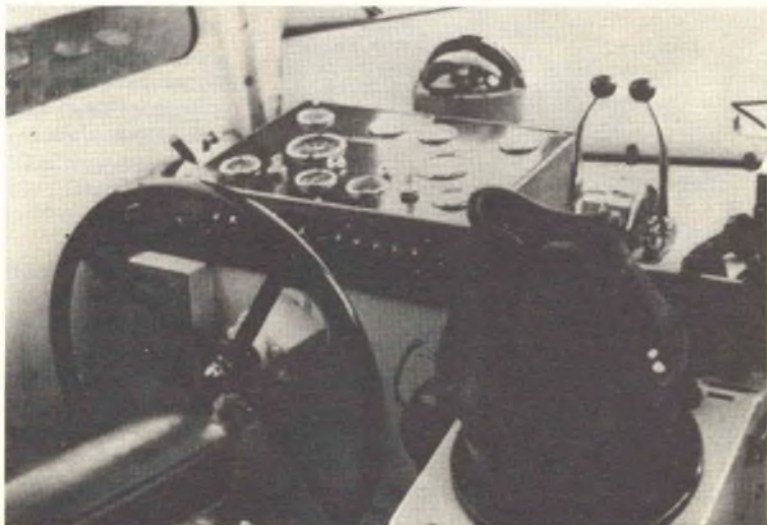
Un radar Kelvin Hughes tipo 17 montato presso la posizione del timoniere in una piccola imbarcazione Trinity House da 12,2 m.
