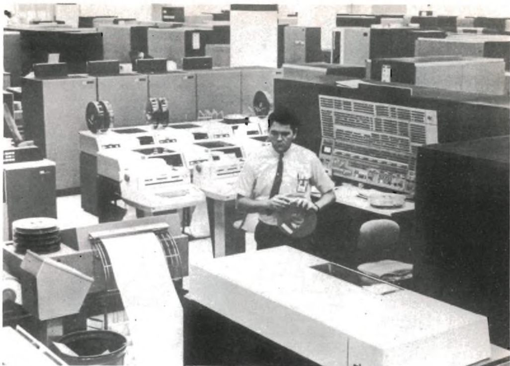
Ecco uno dei Sistemi/360 Modello 75 che costituiscono il Real Time Computer Complex a Houston.
