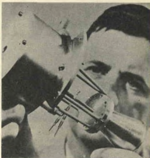
Fig. 5 - Un tecnico specializzato sta mettendo a punto un motore ionico ausiliario impiegabile per le correzioni di rotta di satelliti in orbita.
