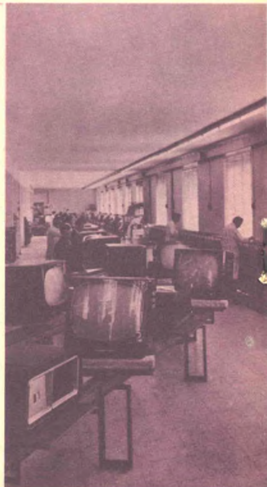
(In basso): Cabine di collaudo poste al capolinea della fabbrica dove convergono le due linee di produzione.
