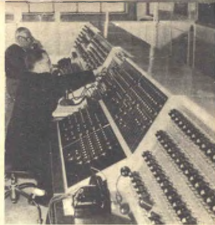
(foto sopra) Il banco più lontano dal quadro è il banco « treni », al quale opera stando seduto il Dirigente del movimento. Sui pannelli del banco sono disposti i pulsanti di comando degli itinerari per i treni, nonché alcuni dispositivi di emergenza.
