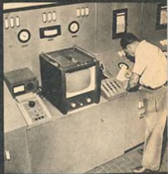
SOPRA: Nella sala di controllo si mettono a punto gli apparecchi di registrazione televisiva.
