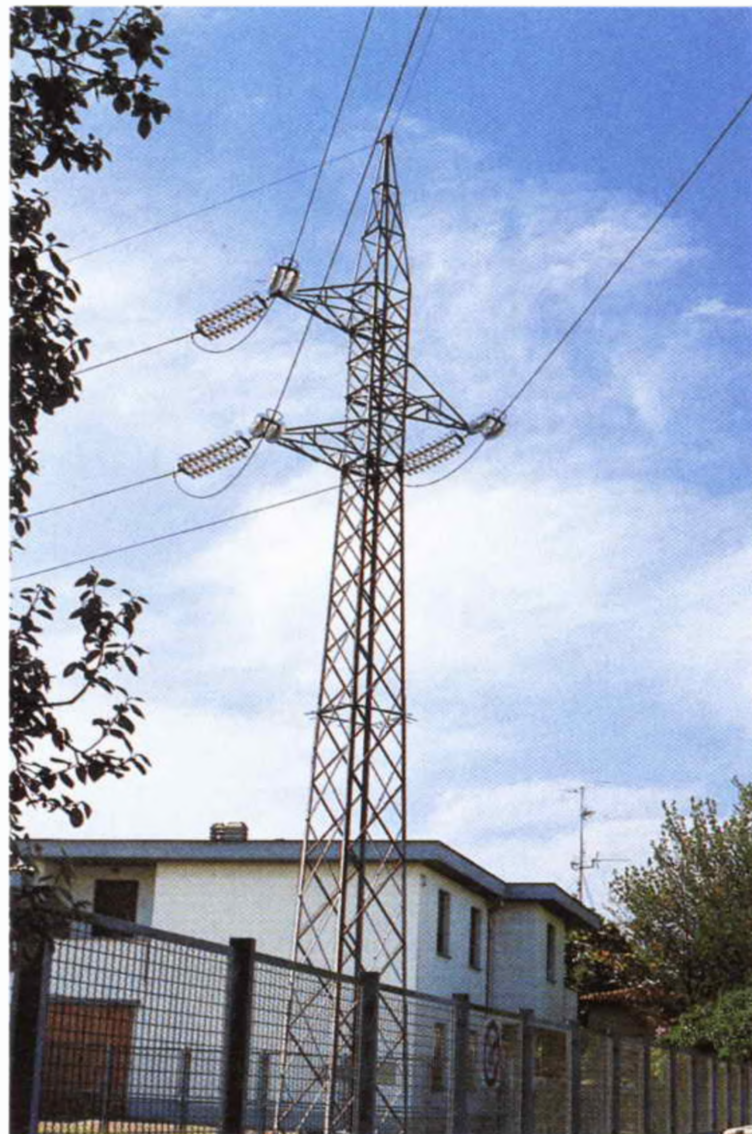
Fig.5 Se vicinissimo alla vostra casa passa una Linea di alta tensione, misurate quale livello ELF è presente sul cuscino del vostro letto. Se rilevate un valore superiore a 0,20 microtesla vi conviene spostare il letto.
