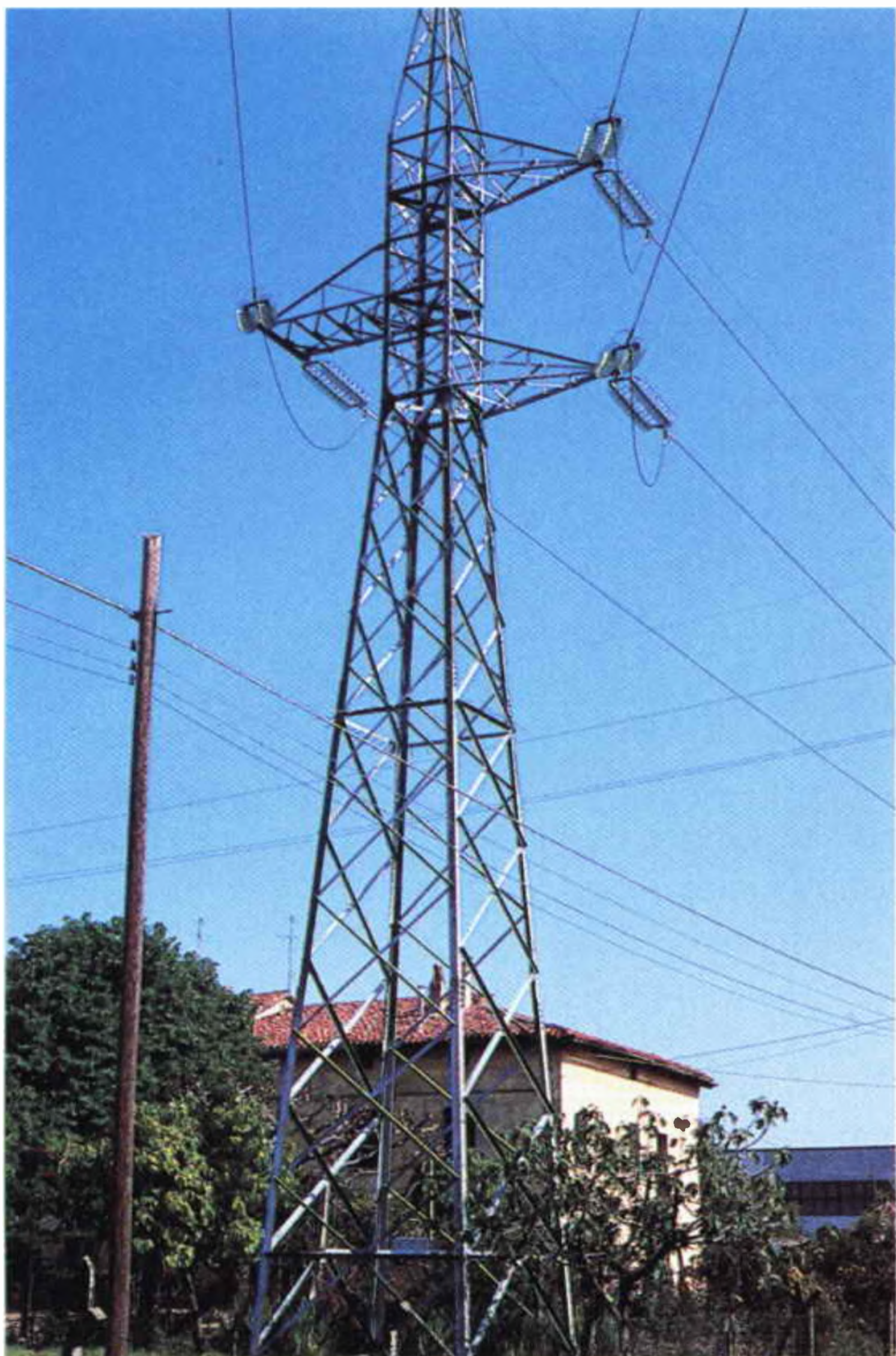
Fig.1 Vicino a molte case sono installate linee elettriche da 380.000 volt che creano intensi campi elettromagnetici. All'ultimo piano di questa casa abbiamo rilevato ben 1,60 microtesla quando invece ne dovrebbero risultare presenti 0,20 microtesla.
