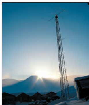
5 - La beam 5 éléments à 30 mètres.
