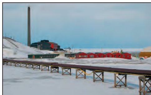
2 - Une particularité de Longyearbyen : toutes les canalisations sont surélevées car le sol, le permafrost, est gelé en permanence.
