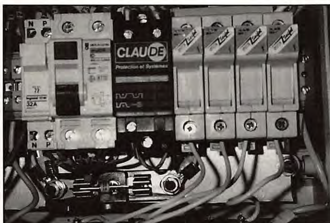
Photo A : en bas le parafoudre - modèle céramique (les parafoudres à gaz et ampoule de verre ne sont plus aux normes).
