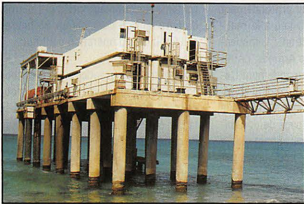
La station "Simon Bolivar" montée sur pilotis.
