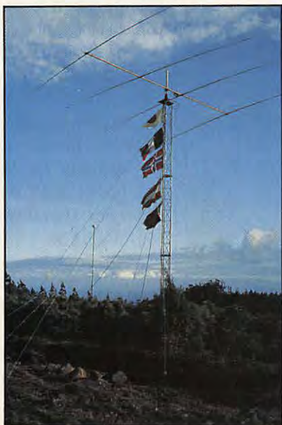
Antenne 20 m terminée.
