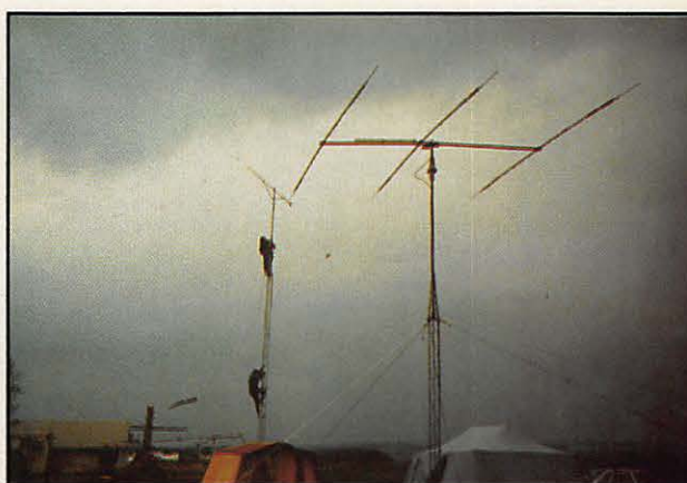
Le montage des antennes.
