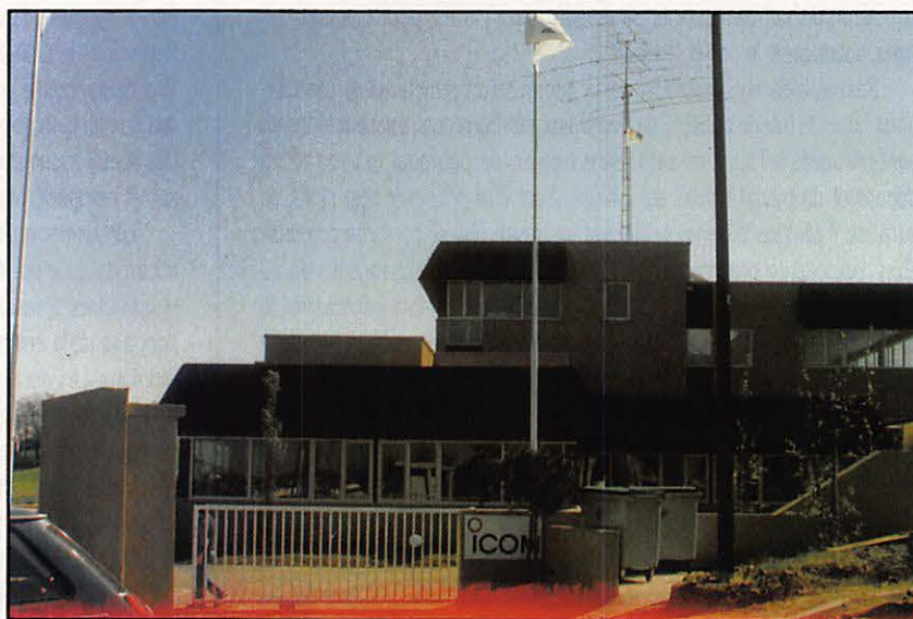
Les nouveaux locaux d'Icom France.
