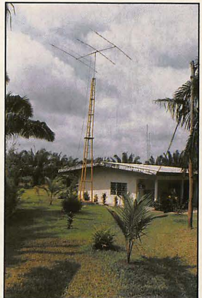
Le pylône supportant la beam CREATE, le sloper et la delta loop.
