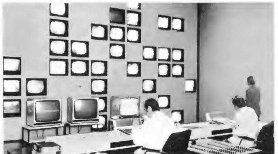
Bild 1. Fernsehzentrale im Münchener Polizeipräsidium für die Verkehrsüberwachung von etwa 35 Straßenkilometer mit 37 fest montierten Kameras
