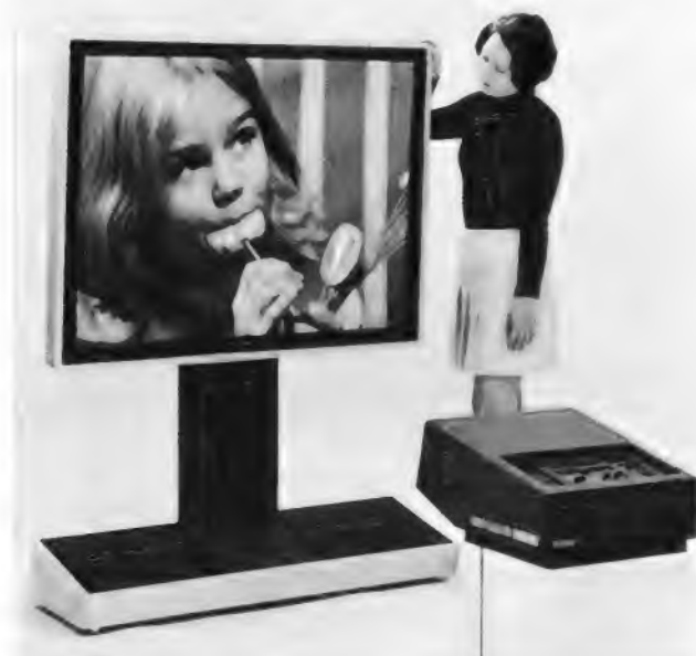
Bild 4. Farbprojektionssystem mit Konsole und Auflicht-Bildschirm. (Davor der Sony-Kassettenrecorder U-matic)
