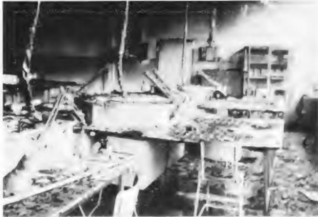
Die völlig ausgebrannte Werkstatt für die überbetriebliche Schulung der Radio- und Fernsichttechniker-Innung Dortmund
