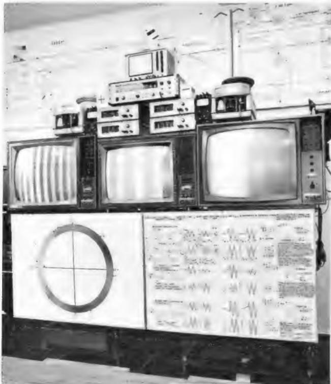
Bild 1. Die Fehler-Simulator-Anlage. Ausrüstung (meist Grundig-Meßgeräte): Digital-Voltmeter DV 33 A, Universal-Frequenzzähler UZ 83 (0 bis 50 MHz), Strahlstrom-Meßgeräte, Hochspannungs-Meßgeräte (bis 40 kV, mit Leuchtwert-Anzeige), Universal-Meßgerät UV 4, Farbbalken-Generatoren FG 4, FG 5 und FG 21, drei präparierte Farbfernsehempfänger
