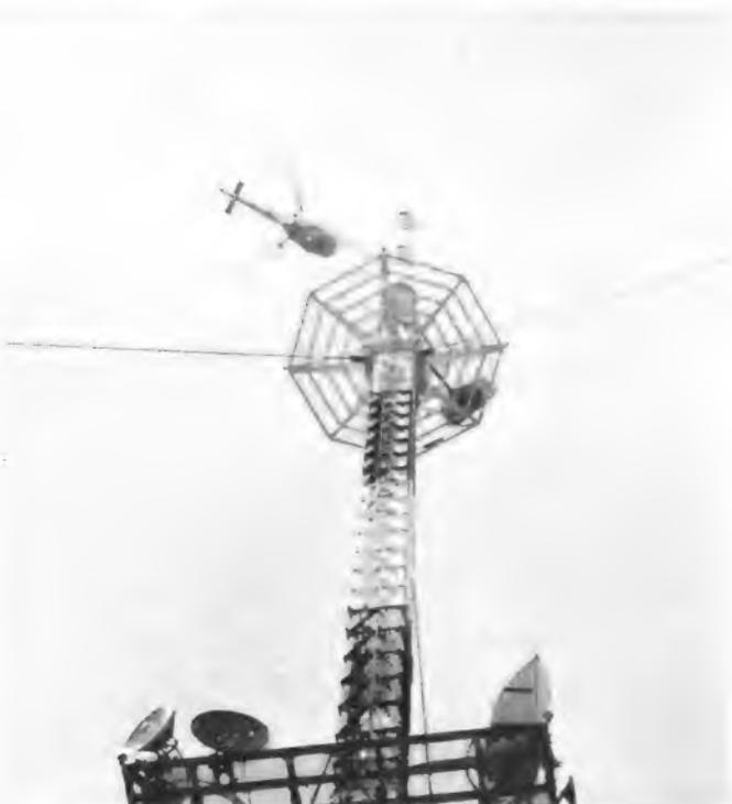
Bild 9. Der Hubschrauber fliegt eine Antennenspitze zum Eichen der Decca-Einrichtung und des Höhenmessers an
