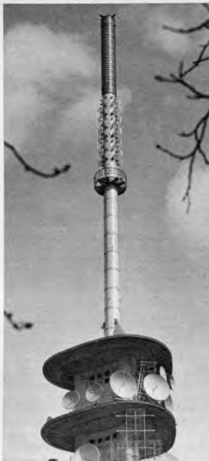
Bild 5. öbL-Antennenanlage mit 24 Viererfeldern K 52322 von Kathrein auf dem Fernmeldeturm München. Im Endausbau sind hier sieben Kanäle im Netz A 1 in Betrieb
