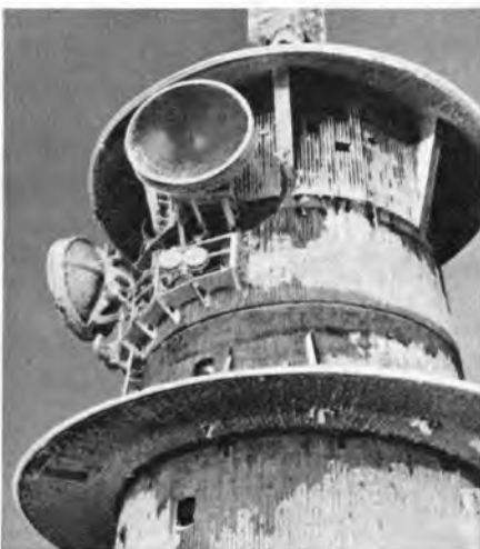
Bild 1. Fernmeldeturm mit 3-m-Parabolantennen, die durch Abdeckungen vor den extremen Witterungsverhältnissen geschützt sind
