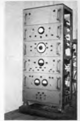
Bild 5. Sendergestell bei DL 1 LS. Oberstes Schubfach: Tonsender, darunter: Bildsender. Im 4. Schubfach befindet sich u. a. der TV-Modulator
