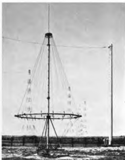
Bild 2. Reusenantennen für die Europaversorgung im 49-m-Band (mit Reflektorwand) in Jülich. Antennen dieser Art, jedoch ohne Reflektorwand, sollen in der neuen Sendestelle ebenfalls aufgestellt werden und die Richtstrahlwände ergänzen
